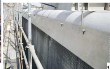
1. Le mur d'eau géant a été inauguré fin juillet. 2. Les panneaux qui habillent le pont sont matricés à 15 mm de profondeur pour produire l'effet cascade. 3. Un échafaudage intégral a permis de poser les panneaux avec une pente de 3 % qui accentue l'effet.
